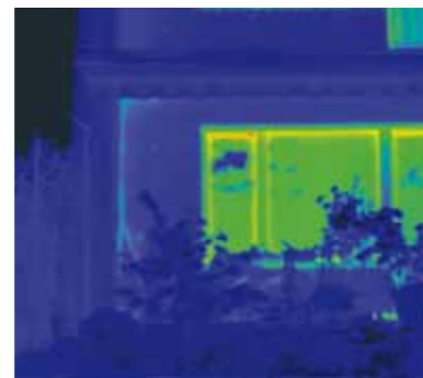
Na zorgvuldige inbouw van nieuwe Schüco Corona CT 70 Accent kozijnen bewijst de thermografie het hoge energiebesparingpotentieel van de investering. Het oorspronkelijke energieverlies wordt maximaal gereduceerd.
